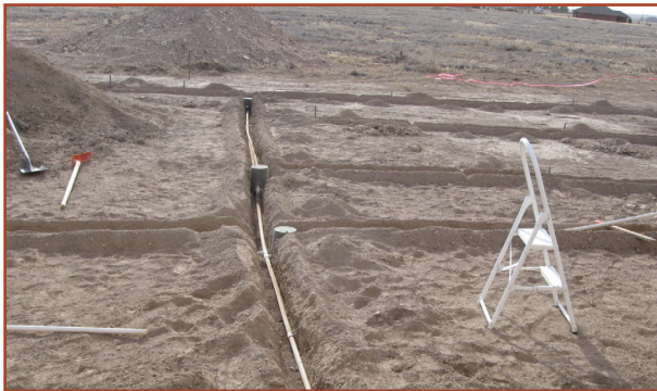
شکل ۴۷- اجرای آبیاری قطره‌ای در باغات پکان
